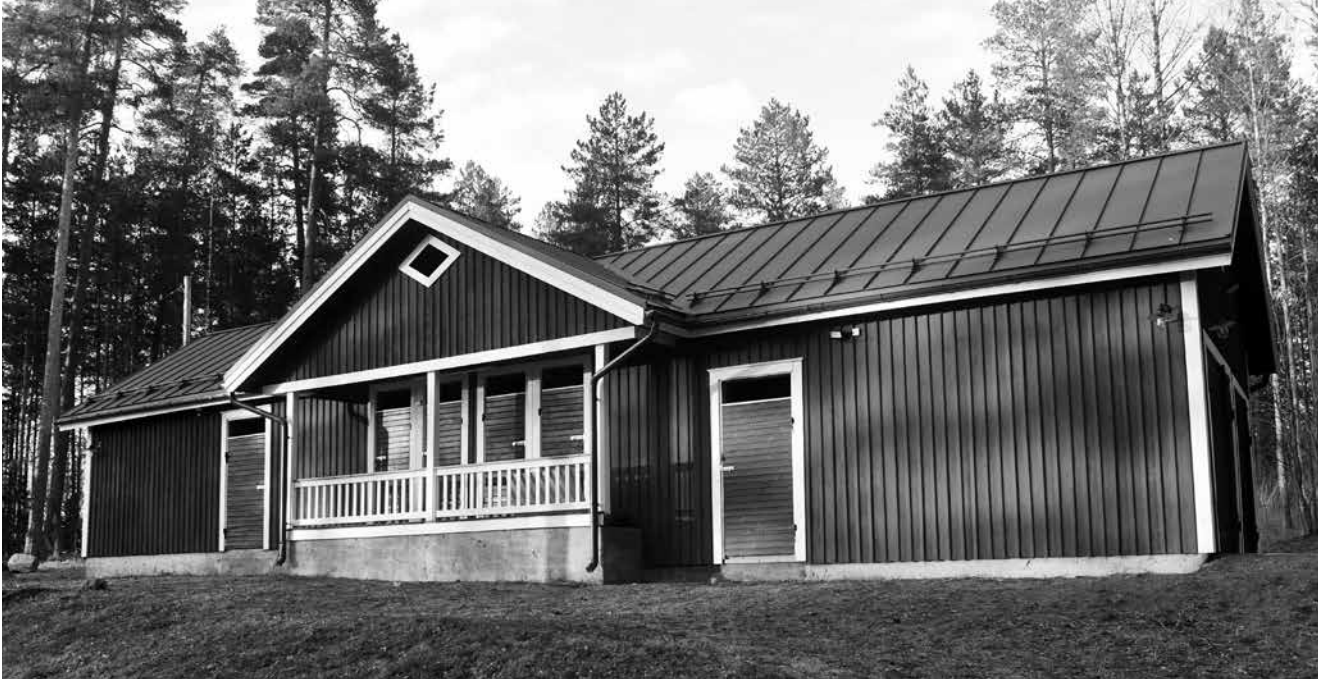
Ulkorakennus on saanut uuden maalipinnan.
