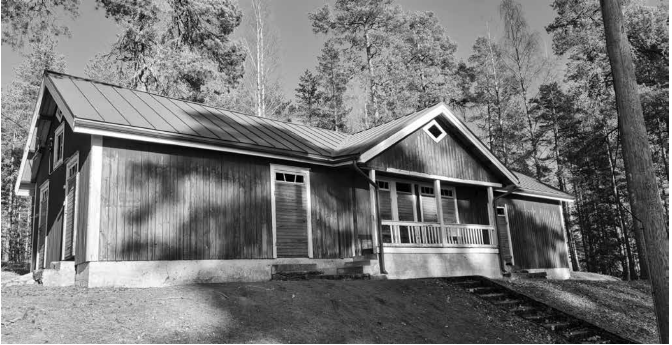
Koulun ulkorakennus vuonna 2025, kun vasta katto oli uusittu.
