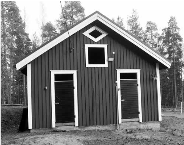
Tänä vuonna on tarkoitus kunnostaa ulkorakennuksen ikkunoita ja uusia sinne portaita.
