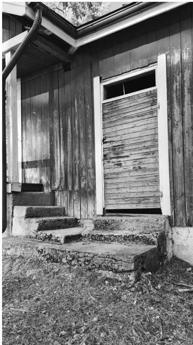
Tarkoituksena on kunnostaa ainakin julkisivun maalipintaa, portaita ja puuosia.
