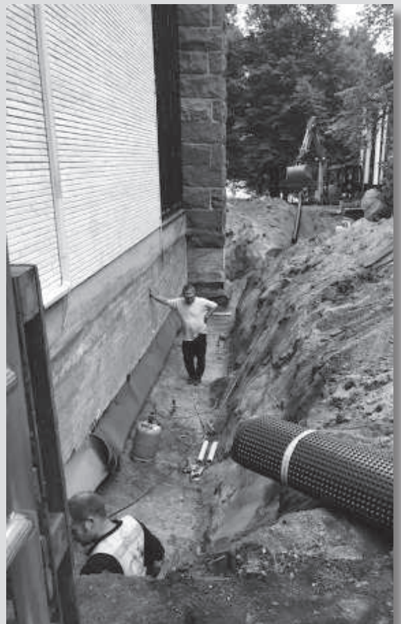
Salaojajorjausten yhteydessä kappelin ympärillä oli miehen mentävä kaivanto.
