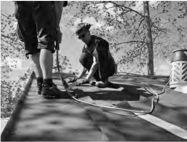
Kattotalkoiden lopuksi kattuhuovan kiinnitys.
