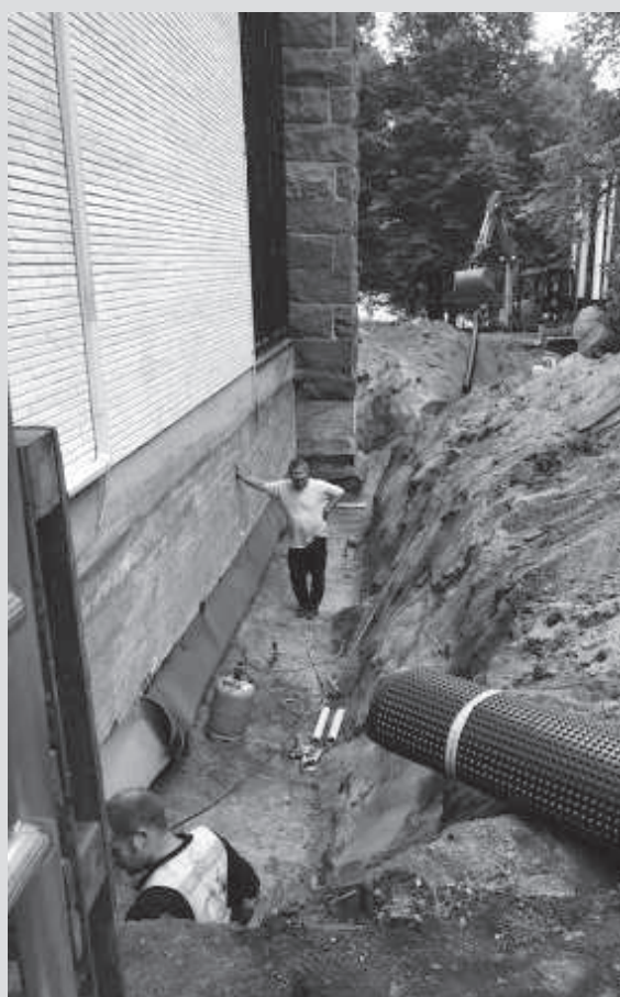
Salaojajorjausten yhteydessä kappelin ympärillä oli miehen mentävä kaivanto.
