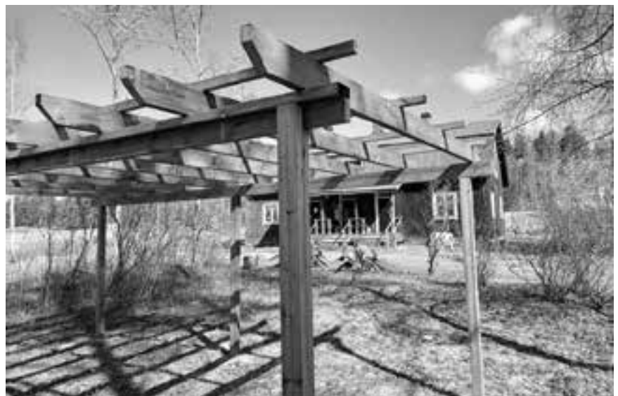
Pergola pystytettiin kirpparin pihalle keväällä – suunnitteilla on vielä valokate ja pohjan tasoitus, jonka jälkeen pääsee luovuus valloilleen.
